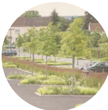
Stationnements qui captent et filtrent l'eau
